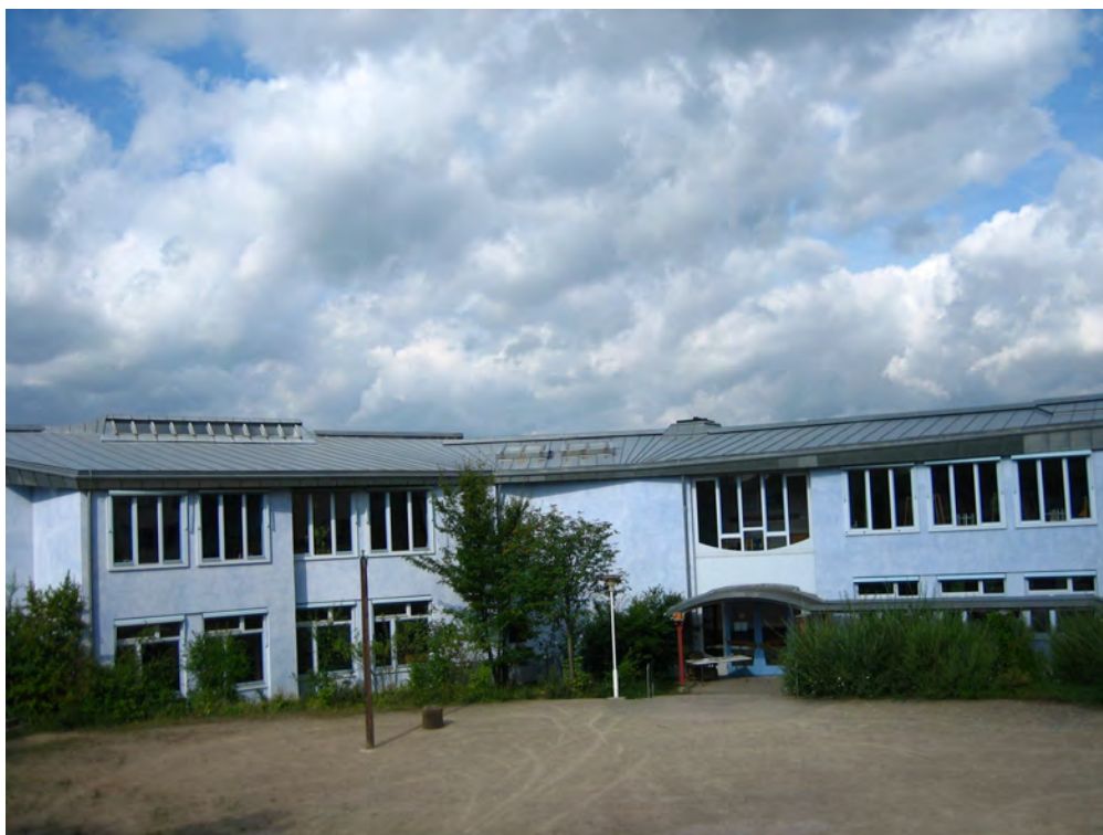
Abbildung 4.2: Blick auf den Oberstufenbau der Waldorfschule Würzburg
