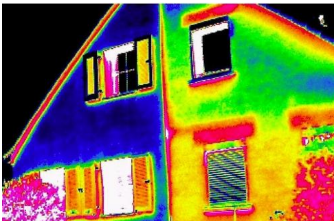
Abb. 4.36: Thermogramm eines Zweiparteienhauses [INTQ48]
