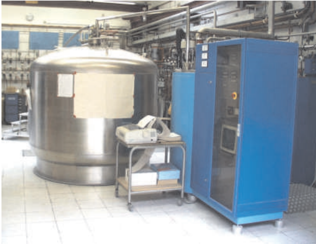
Helium - Verflüssigungsanlage
