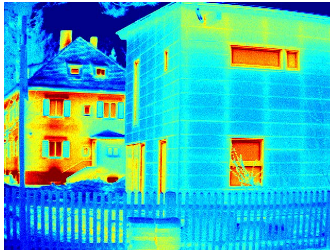
Kaum noch CO 2 -Ausstoß durch super-wärmegeämmte Häuser mit kalten (blauen) Wandoberflächen, während ungedämmte Altbauten mit warmen (orangeroten) Wandoberflächen wahre CO 2 -Schleudern sind.
