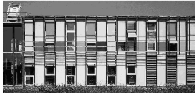
Südfassade des ZAE Bayern (Zentrum für angewandte Energieforschung) mit verschiedenen Feldern zur schaltbaren und transparenten Wärmedämmung.
