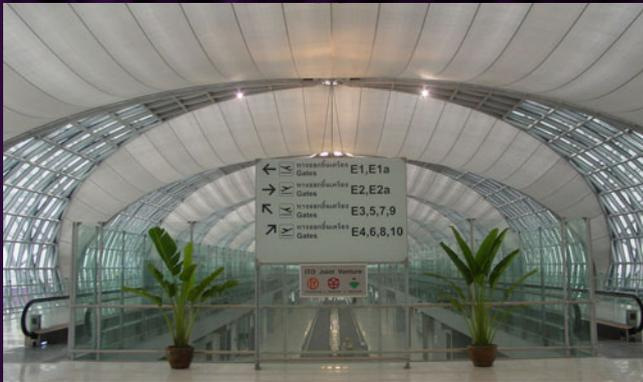
Textile Architektur mit wärmereflektierender Beschichtung in einem Flughafen
